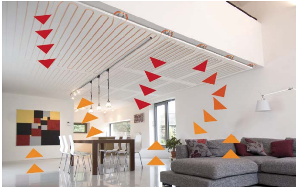
Strahlungswärme: Treffen die Strahlen auf einen festen Körper, werden sie in Wärmeenergie umgewandelt.
